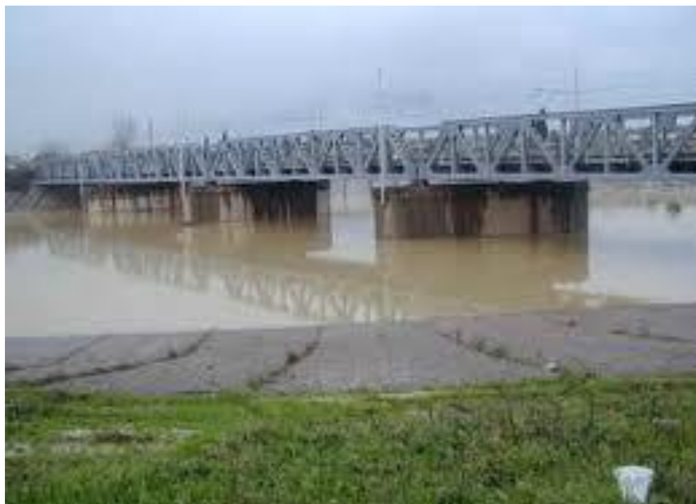
Scolmatore d'Arno, lato mare
